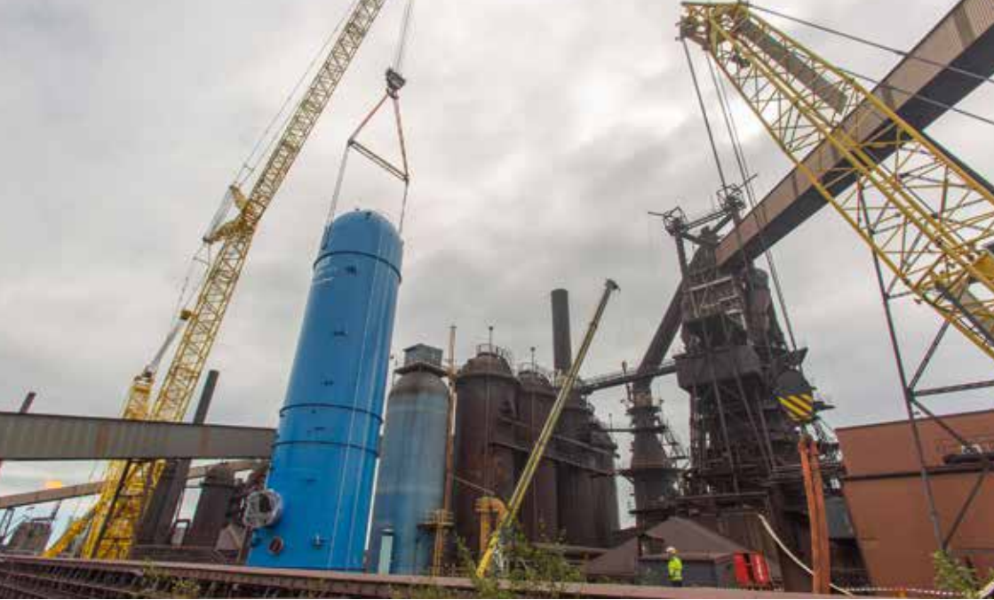
Montage des Winderhitzerkessels 47 bei SSAB Oxelösund (Foto: SSAB)
