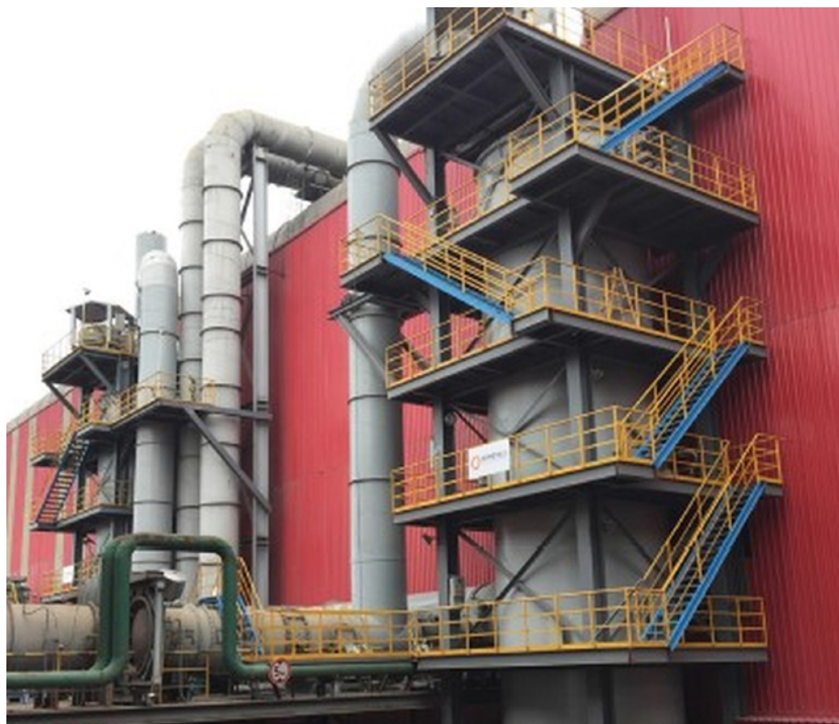
WESP-Filtertürme für die BOF-(LD)-Konverter 1 und 2 bei Changzhou Eastran Special Steel Co., Ltd. (Foto: Primetals Technologies)
